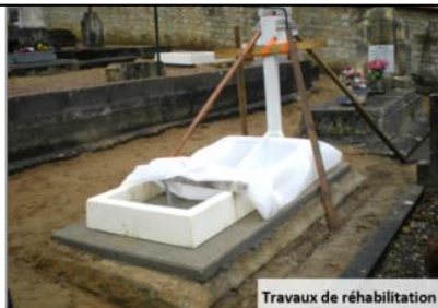
Travaux de réhabilitation
